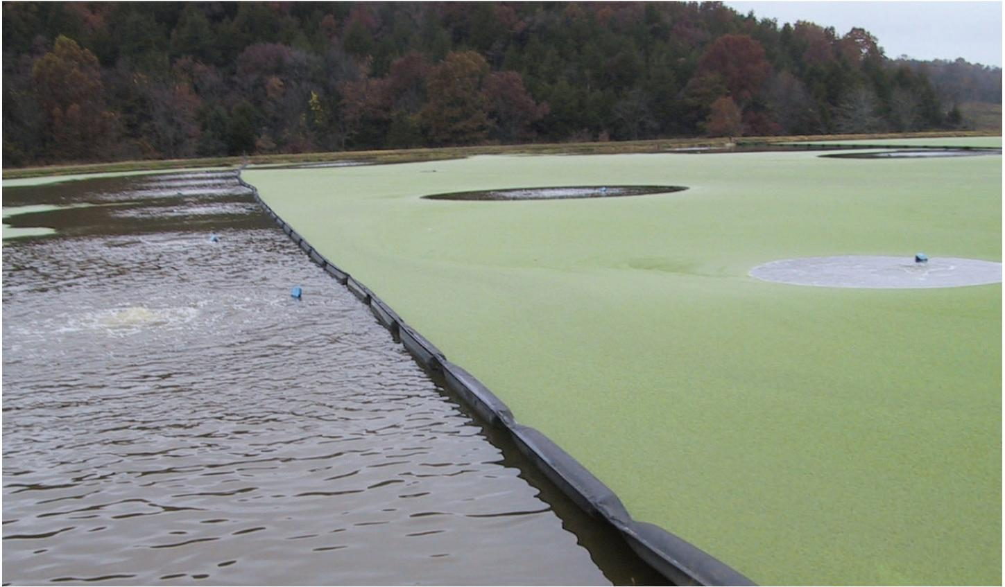
バツフルは、浄化が必要な湾内等で、水流を弱め、汚泥が沈降するための時間を稼いでくれるシステムです。
